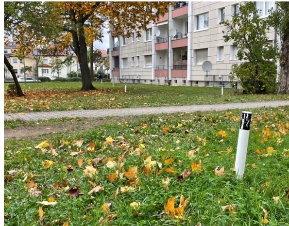
Abb. 13 & 14: Feuerwehrezufahrt mit Markierung durch Pfosten
