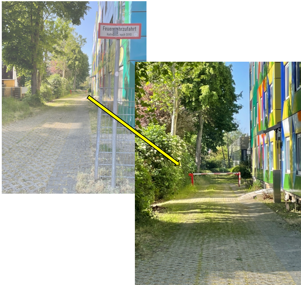
Abb. 6: Schranke in einer Feuerwehrezufahrt mit Feuerweherschließung der Stadt Rüsselsheim
