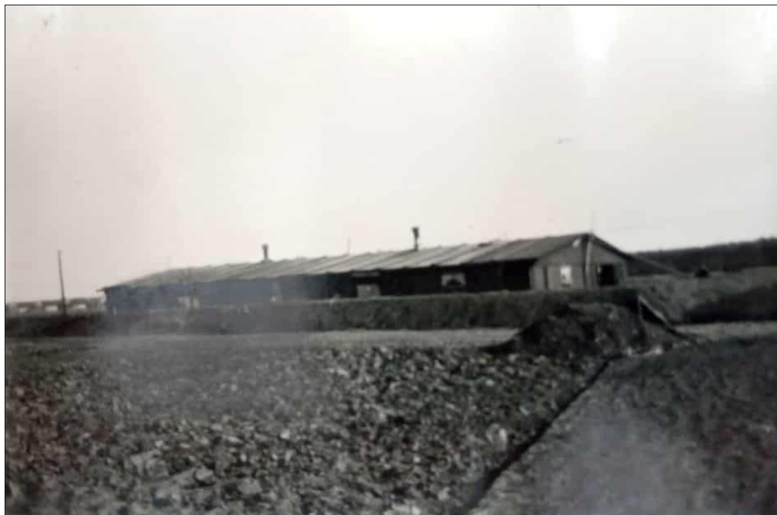
Blick auf eine der Barracken der 1. Batterie der schweren Flakabteilung 637 am alten Standort Rüsselsheim (Bildquelle: Fotoalbum K.-H. Cordier, Stadtarchiv Rüsselsheim).
