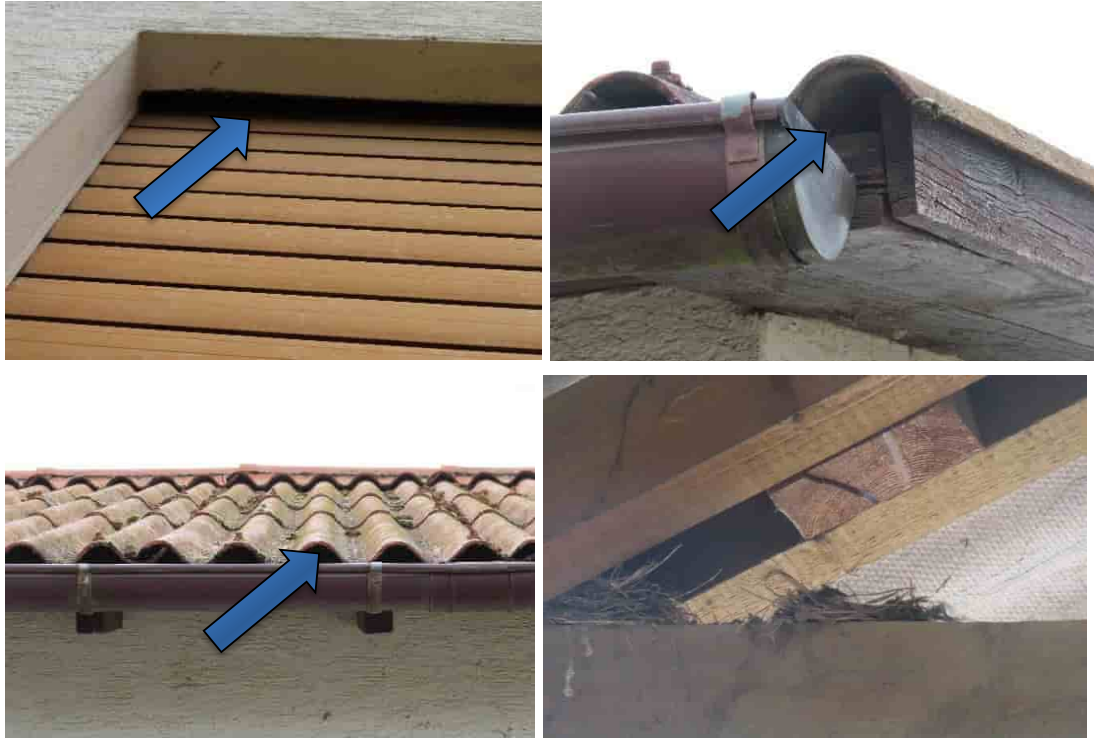
Abbildung 3: Beispiele von Quartiermöglichkeiten für spaltenbewohnende Fledermausarten und Brutplatzpotenzial beispielsweise für Haussperlinge, unten links zwei Nester in einer Scheune auf einem Balken.
